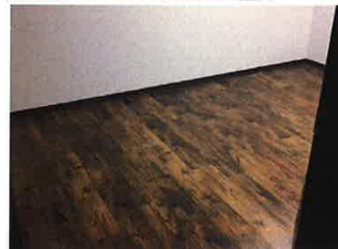
〔写真1〕 壁際から 30cm分を残す 間仕切り壁から約30cm までを残して床材を取り 除いた状態。一般的な丸 鋸で施工できる(写真:この ページは妹尾建設)
