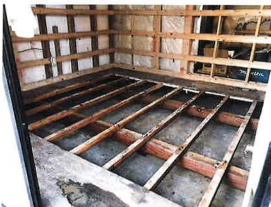
〔写真1〕 壁際から 30cm分を残す 間仕切り壁から約30cm までを残して床材を取り 除いた状態。一般的な丸 鋸で施工できる(写真:この ページは妹尾建設)
