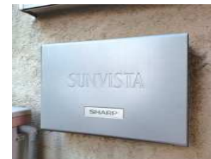
パワーコンディショナー(パワコン)
