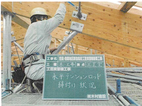
(建て方 架構材の組立)
