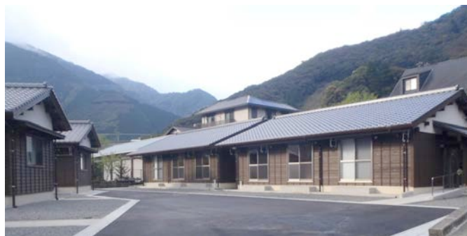
(完成した村営住宅)
