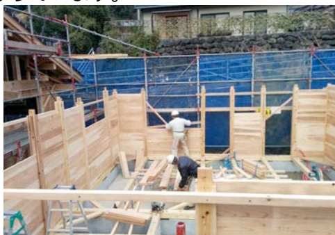
(落とし込み板壁の施工)
