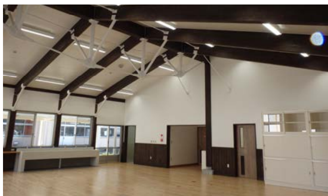
(建物内観 (テンション金物併用大断面架構))
