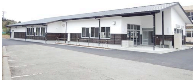
(建物外観 (腰壁に杉下見板張り))
