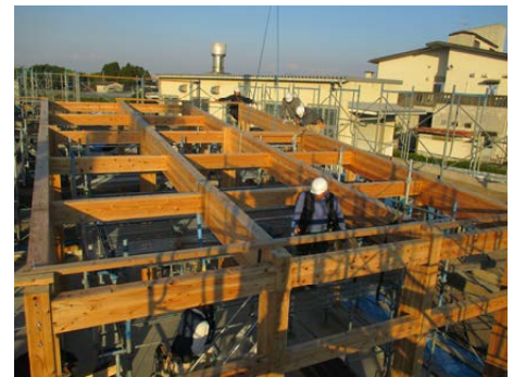
(二方向ラーメン構法での建て方)
