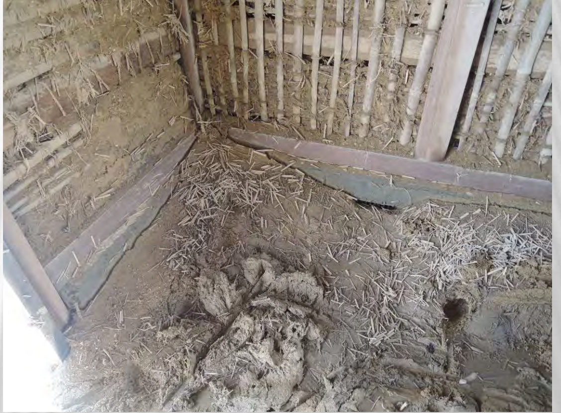
伝統工法の土壁建物の典型的な例
