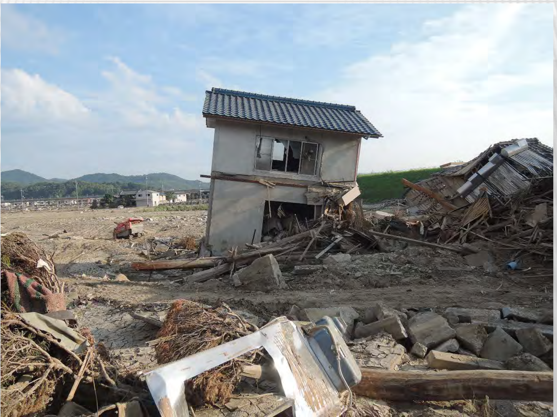
「高馬川」 右岸決壊場所付近（水流による被害）
