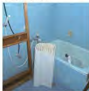
浸水した在来工法の浴室
