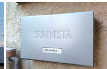
パワーコンディショナー(パワコン)
