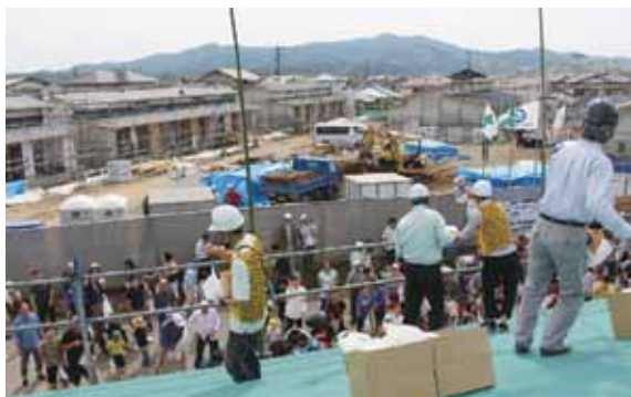
災害公営住宅 上棟式
