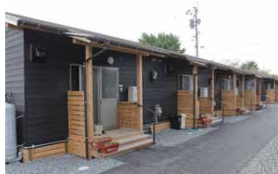
建設された木造仮設住宅(朝倉市林田仮設団地)
