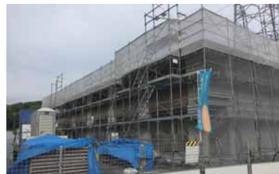
各地で建設が進む災害公営住宅
