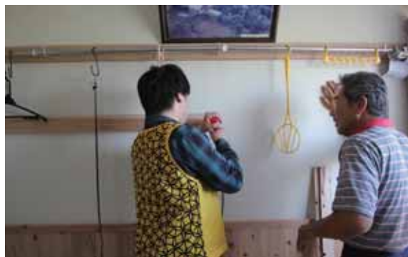
長押の設置作業
