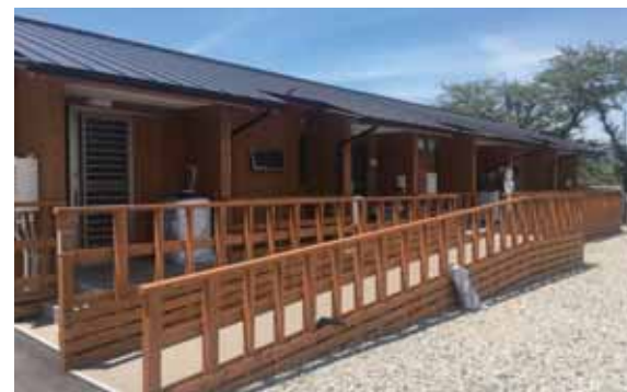
玄関を引き戸にするなどしたバリアフリー型木造仮設
