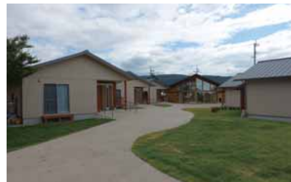
西原村河原地区の災害公営住宅と集会所
