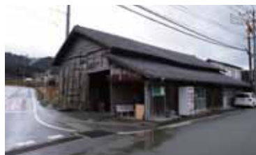
南阿蘇村長野地区で自主的に開設された「みんなの家」
