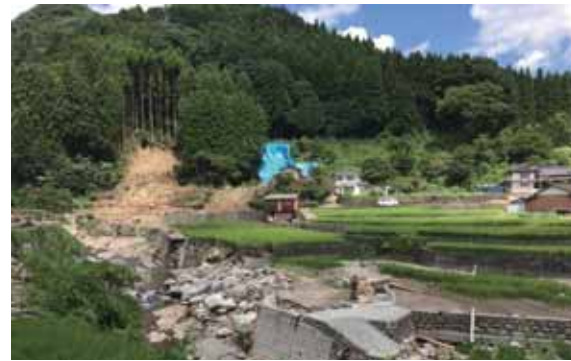
川が土地を削り取ると同時に土砂崩れも発生している(宝珠山地区)
