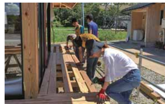
8月23日「みんなの家」縁側床張り
