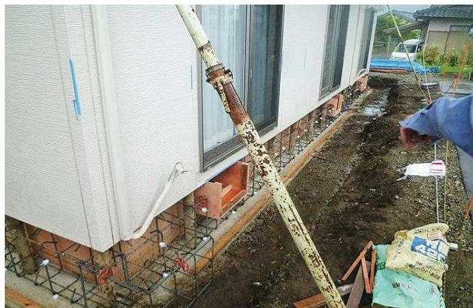
写真10 阿蘇市木造仮設住宅の基礎の補強(平成26年)
