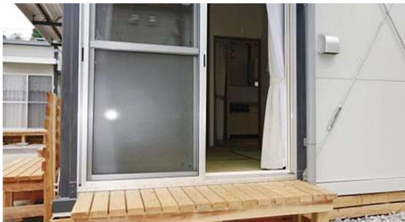
写真11 プレハブ仮設住宅に設けた掃出し窓と濡れ縁
